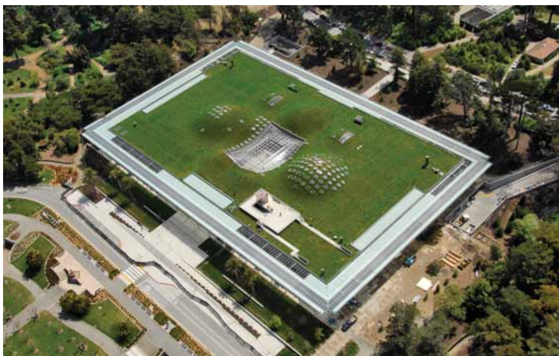
A combinação de painéis solares e telhado verde garante alta eficiência energética à sede da Academia de Ciências da Califórnia, nos Estados Unidos.
