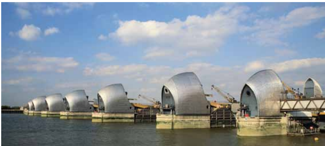
Barragens com bombeamento, instaladas no rio Tâmis, em Londres, evitam o refluxo dos esgotos num cenário de aumento do nível do mar.
